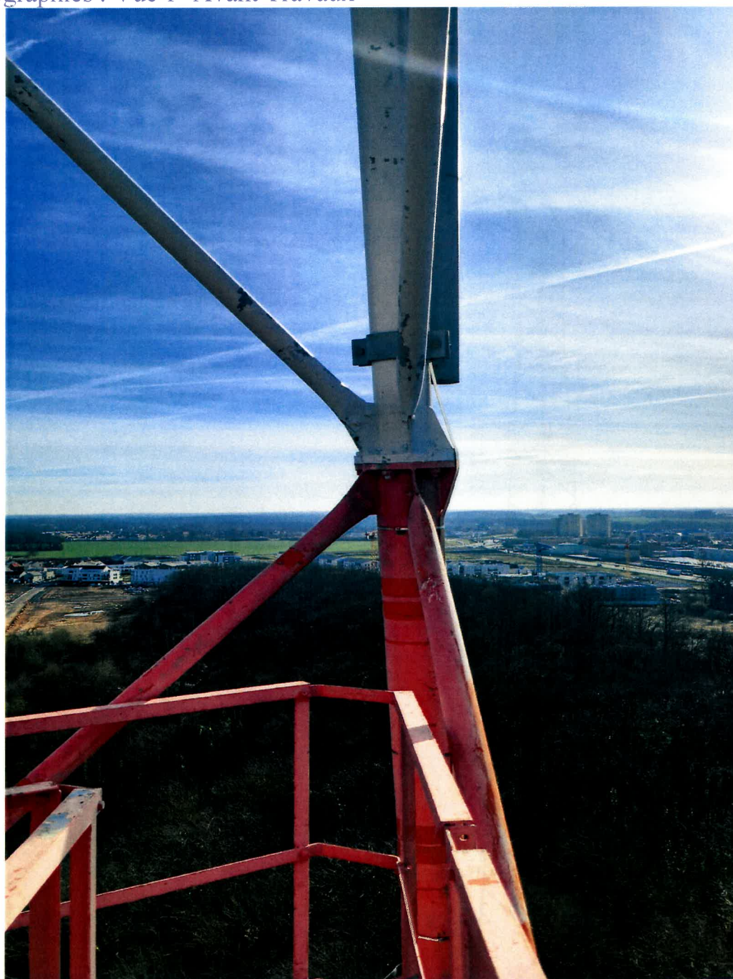
Photographies : Vue 1- Avant Travaux
