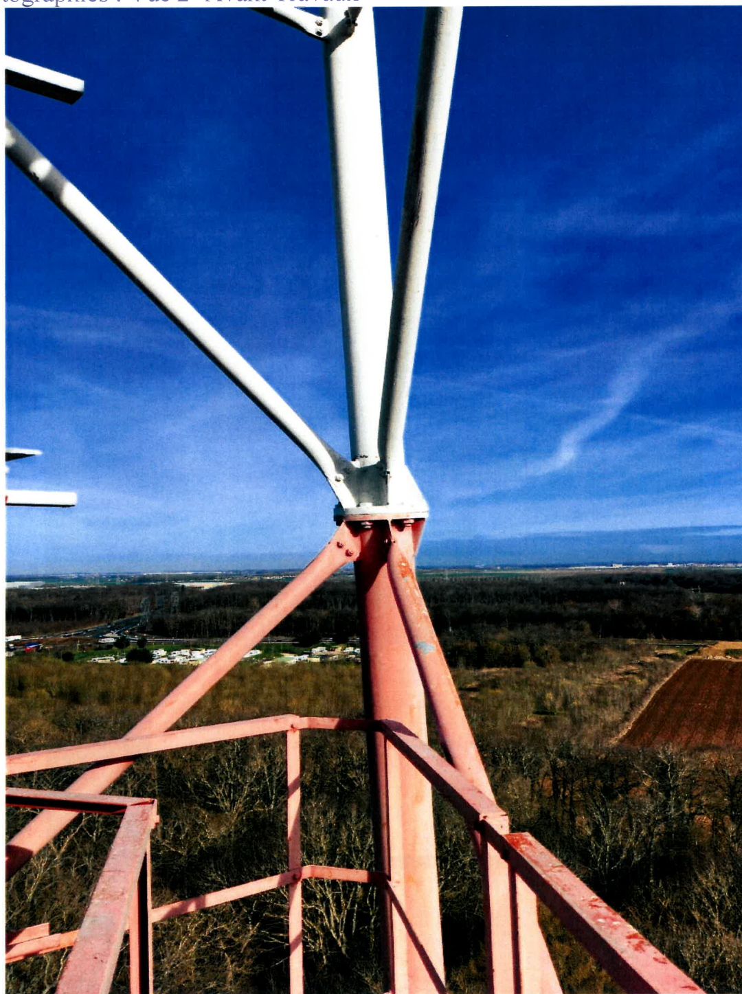
Photographies : Vue 2- Avant Travaux
