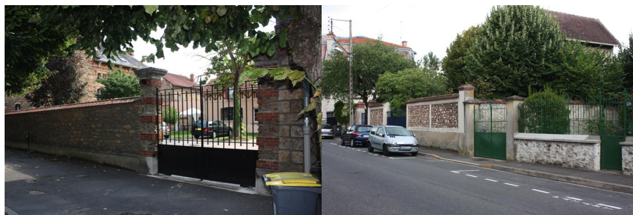
Dispositions traditionnelles des murs de clôture qui assurent la cohérence du tissu urbain en instaurant une continuité sur rue
