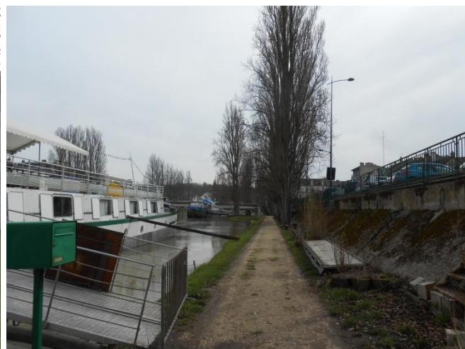
Le quai de la Reine Blanche, au droit de la place Praslin à aménager de manière qualitative.
