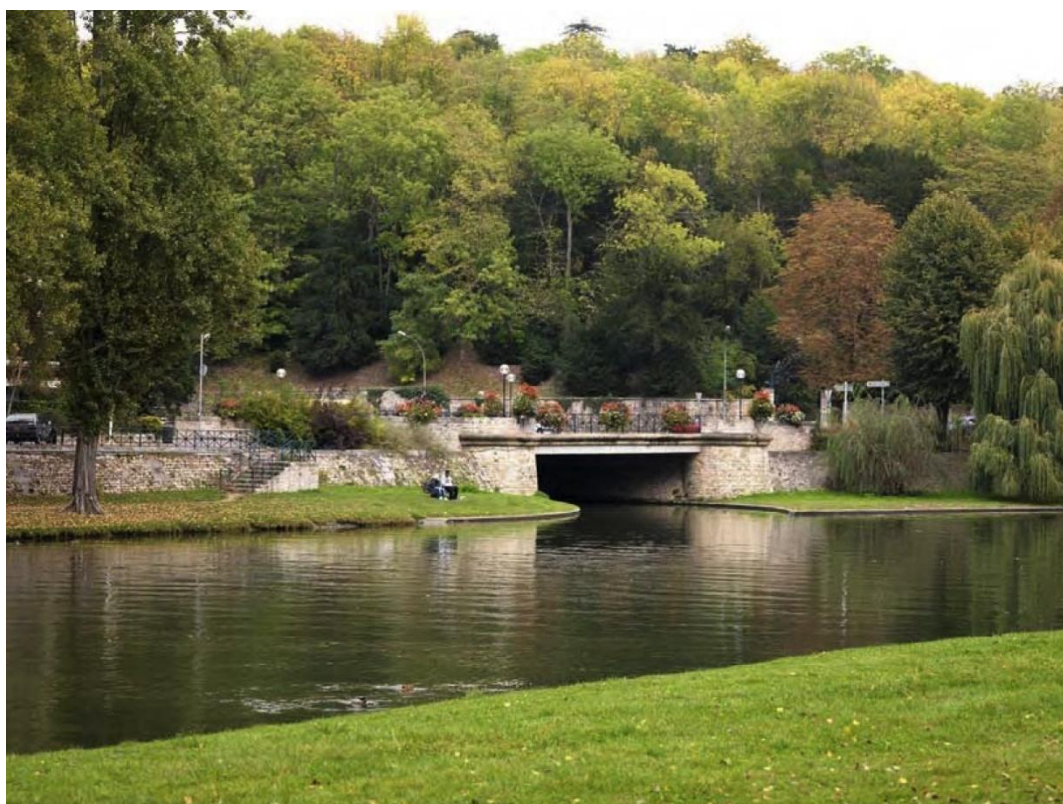
Le pont d'Almont reconstruit dans le troisième quart du XX ème siècle. Les culées existantes datent de sa construction antérieure, en 1842.
