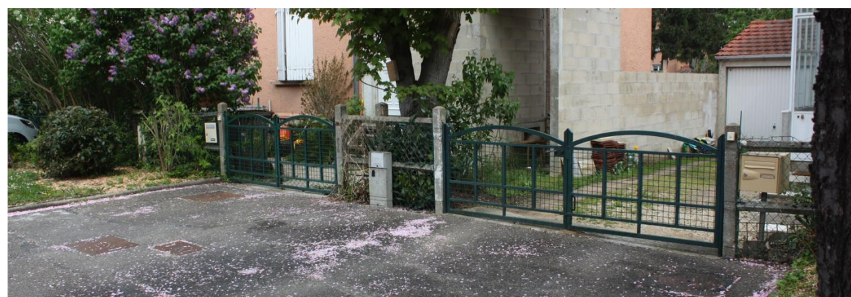
Dispositions d'origine des clôtures à conserver pour pérenniser l'homogénéité de l'ensemble.
