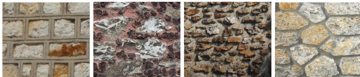
Différents types d'appareillage et de joints (creux, ruban, rocaillage...)
