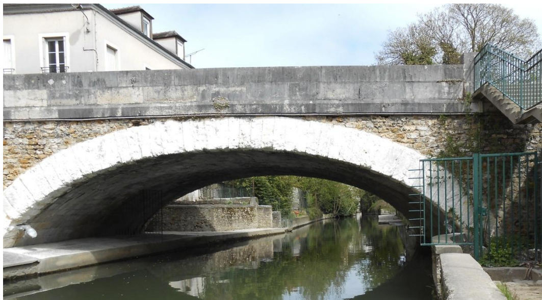
Le pont de Saint-Liesne fût construit en 1841. Des pierres de taille de calcaire et de meulière ont été utilisées pour sa construction.
