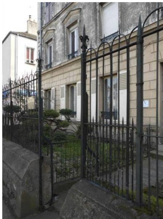
Sur l'avenue Thiers, jardinet ayant conservé son muret et sa grille d'origine.
