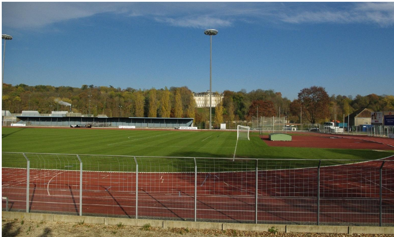
Le site du complexe sportif possède des vues exceptionnelles sur le parc Faucigny-Lucinge et le château de Vaux-le-Pénil.
