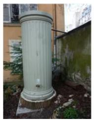
Citerne exterieure raccordée sur la descente d'eaux pluviales
