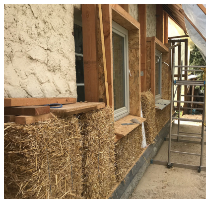
Construction en paille Source : CAUE 95
