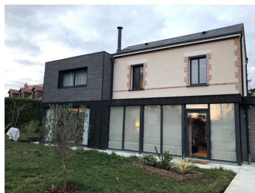
Exemple d'extension latérale et en façade
