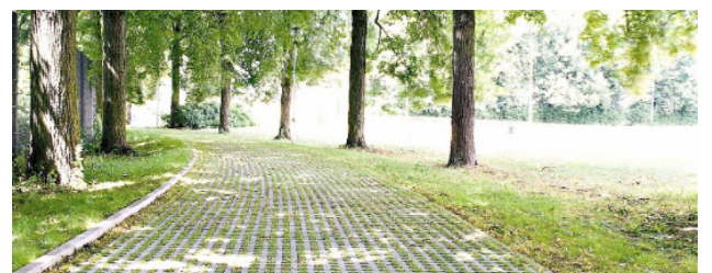
Revêtement de circulation douce semi-perméable
