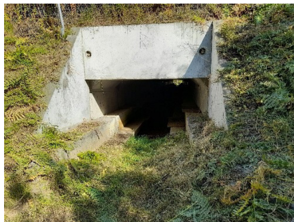
Tunnel sous une voie, Source : Cerema
