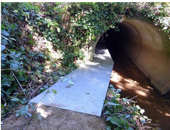
Raccordement d'une buse à la berge, Source : Cerema
