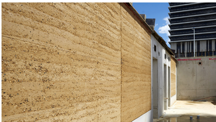
Construction en terre crue à Nanterre Source : ArchitectureTerreBois
