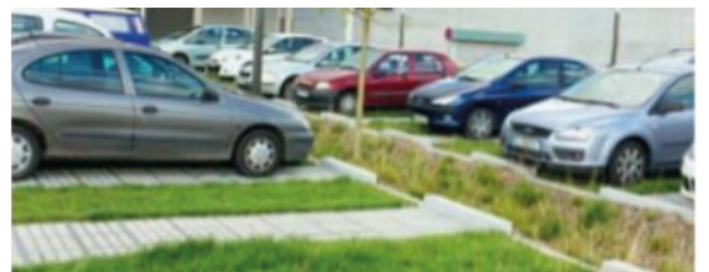
Noue végétalisée avec infiltration gravitaire du ruissellement
