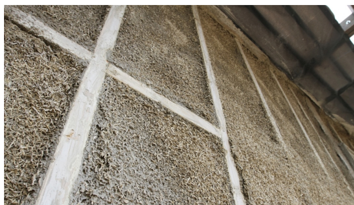
Construction en béton-chanvre, Source : CAUE 77
